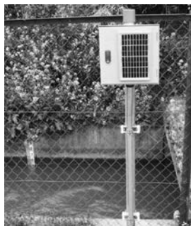
写真-1 用水路に設置
